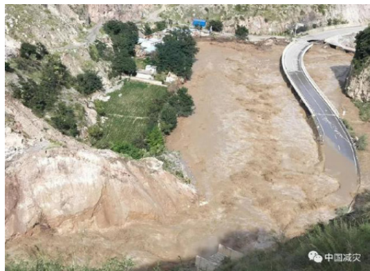
■ 7月，甘肃甘南州舟曲县南峪乡江顶崖滑坡导致道路中断（来自中国减灾网）
