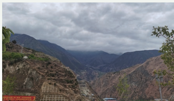
川藏铁路项目现场图
