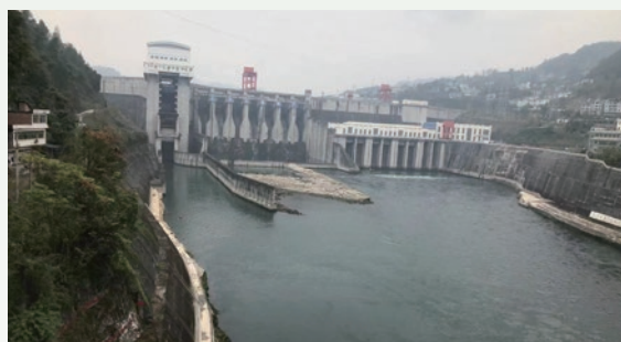
乌江沙沱水电站项目现场图
