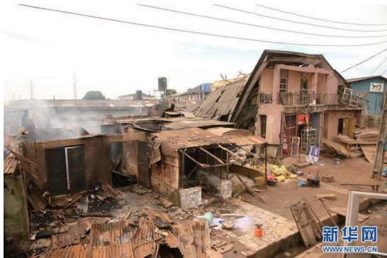
图片来自新华网：10月8日在尼日利亚拉各斯拍摄的在燃气站爆炸事故中受损的房屋
