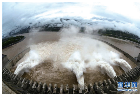
■ 图片来自新华网：2018年7月5日，江水通过三峡大坝泄洪深孔下泄。当日8时，三峡水库入库流量达到5.1万立方米每秒，出库流量4万立方米每秒。
