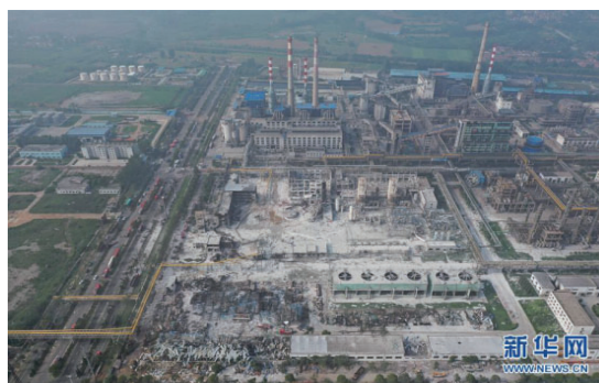
图片来自新华网：无人机拍摄的爆炸现场
