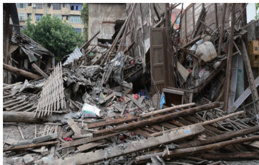
■ 图片来自新华网：四川长宁县双河镇垮塌的房屋
