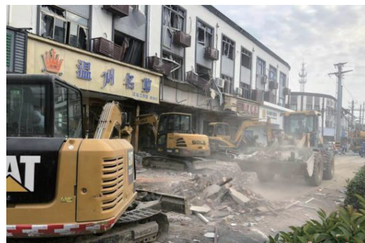
■ 图片来自新华网：挖机和铲车正在清理爆炸现场。
